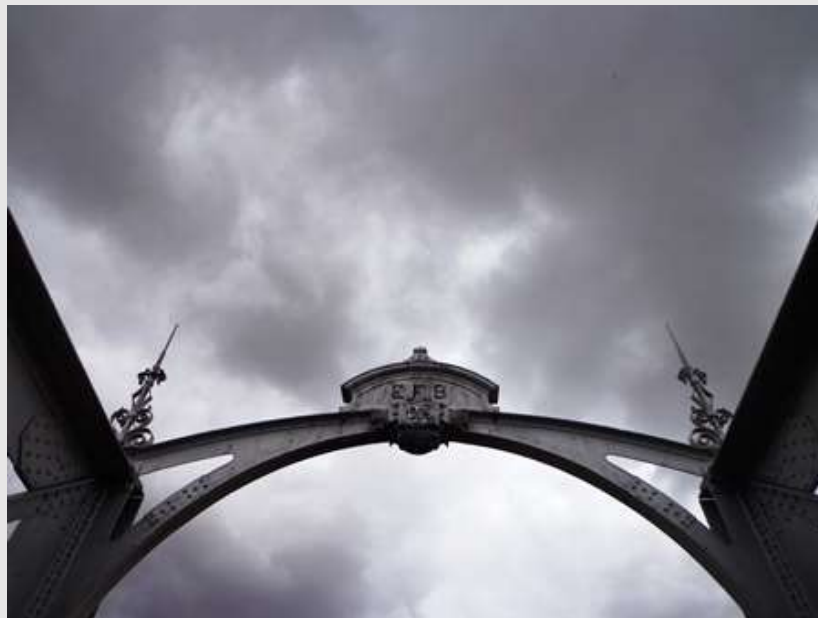
Detalhe da Ponte Ferroviária de Senador Pompeu (CE). [2010] Fotografia: Aterlane Martins.
