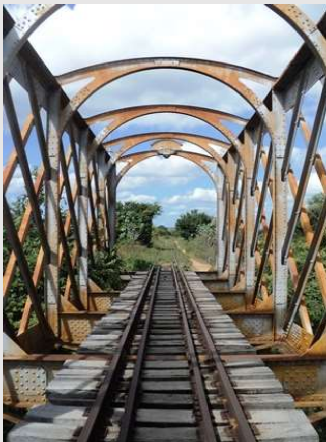
Ponte Ferroviária de Senador Pompeu (CE); trilhos. [2010] Fotografia: Aterlane Martins.
