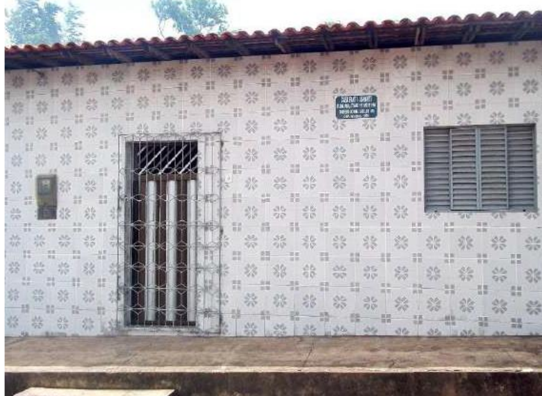
Figura 1: Casa Fanti Ashanti
