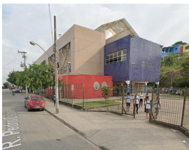
Figura 1: Entrada da Escola Municipal Tatiana Chagas Memória, Rua Pedro Osório, 360, Jardim Maravilha, Guaratiba/RJ
